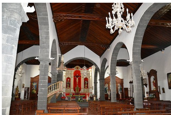
Innenraum der Iglesia de San Ginés
