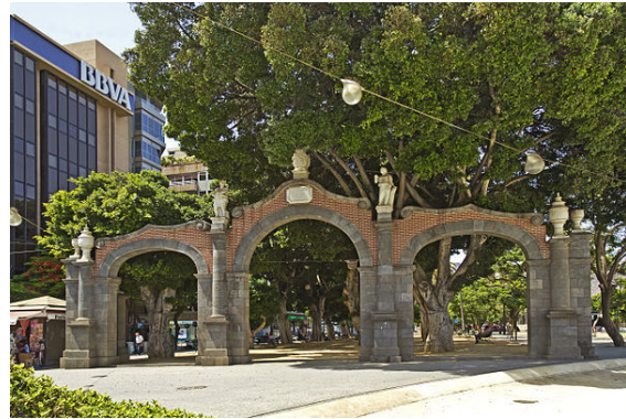
Rekonstruierter Eingang zur Alameda del Duque de Santa Elena
