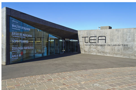
Oberer Eingang des Gebäudes
